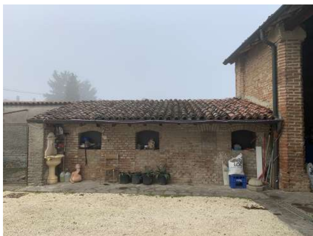
Foto degli accessori esterni a confine con il mappale 42
